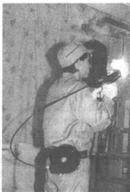
图 7-14 半自动连续焊条施焊
