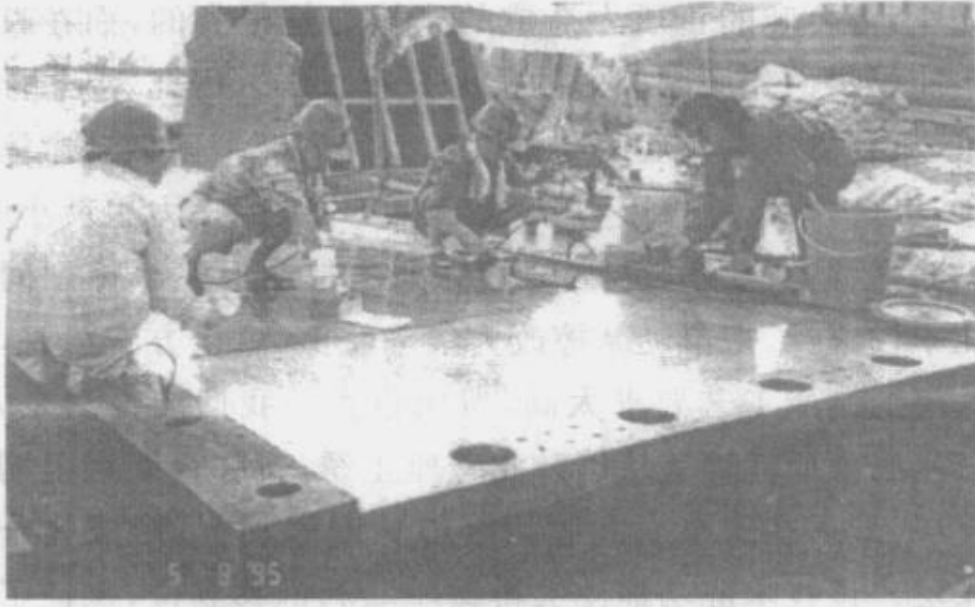
图 7.4 在西陵长江大桥鞍座底板上电刷镀减摩铜镀层
